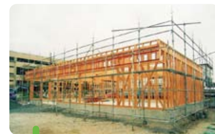
建设中的店铺
