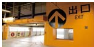
立体駐車場の大型誘導サイン
