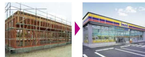
工事中の店舗
