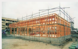
工事中の店舗
