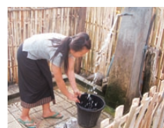
ラオスにできた給水施設
