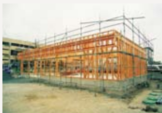
工事中の店舗
