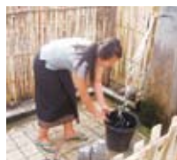
ラオスにできた給水施設
