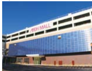
「イオンモール船橋」(千葉県) エコストア12号店。 施設全体の照明の97.6%を LED化しました。
