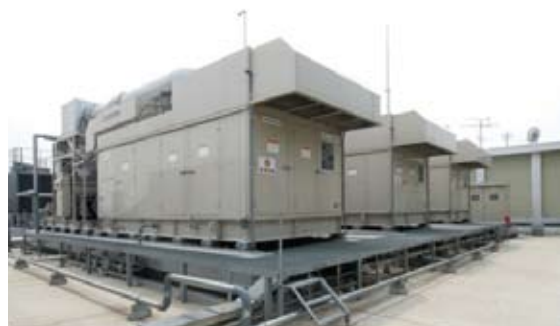
自家発電設備の設置
