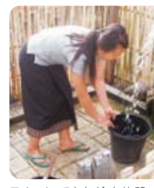
ラオスにできた給水施設
