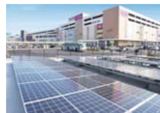
太陽光パネルを設置
