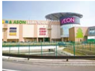
「イオンレイクタウン」(埼玉県) エコストア8号店。 国内商業施設最大級となる ソーラーパネルを設置しました
