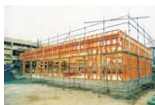
工事中の店舗
