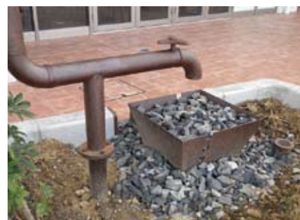
雨水を下水管に直接流さずに土壌へ浸透させて浄化する「雨の庭™」
