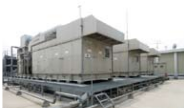
自家発電設備の設置
