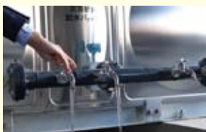
飲料水を確保するため、380トンの受水槽に仮設給水口を設置
