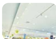
LED照明への切り替え
