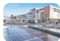
太陽光パネルを設置
