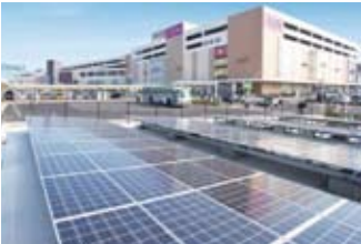
太陽光パネルを設置
