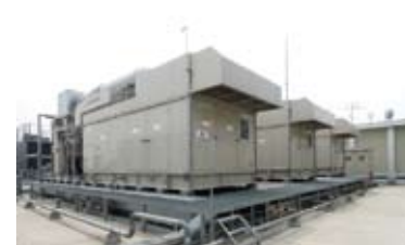
自家発電設備の設置
