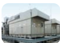
自家発電設備の設置
