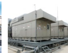
自家発電設備の設置
