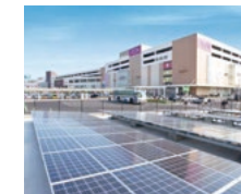
太陽光パネルの設置
