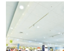
LED照明への切り替え
