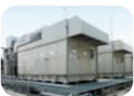
自家発電設備の設置
