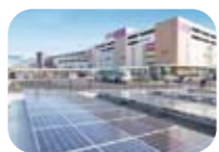
太陽光パネルを設置
