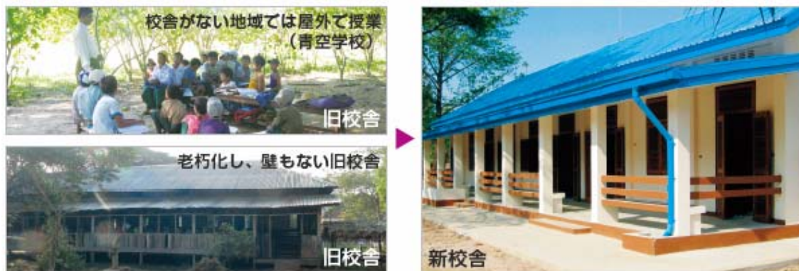
ミャンマー学校建設支援事業で新しく建てられた校舎
