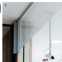
1. 防煙垂壁の素材の変更と軽量化 2. 天井のスケルトン化
