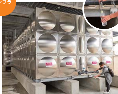
停電・断水時の飲料水を確保するため、受水槽に緊急用給水口を設置
