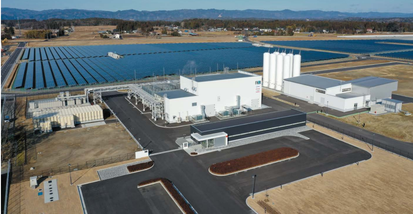
FH2Rの敷地はおよそ22ha(東京ドームの4倍以上)。そのなかに水素製造装置が設置された巨大な建屋、8本の水素貯蔵タンク、水素搬送設備、管理棟などがあるが、設備を動かす電力をまかなう太陽光パネルが多くの面積を占めている。常時10名前後が勤務し、実用化に向けて水素製造時の適切な運転の条件や使用による劣化など、さまざまなデータを取っている
