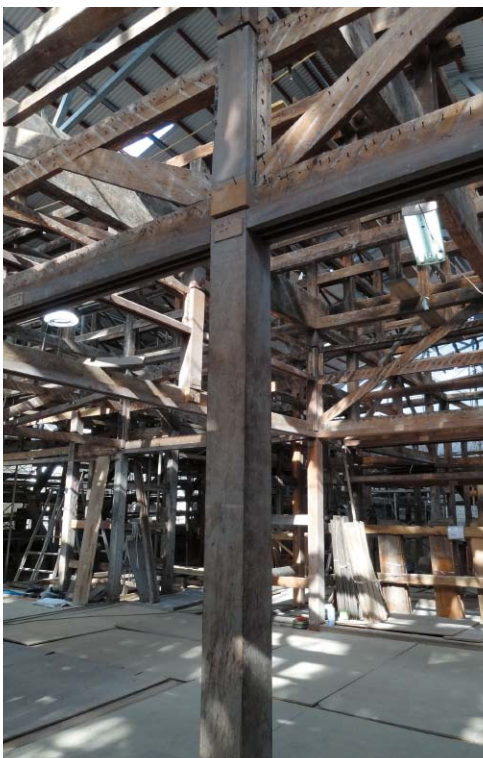
名護市で見た、築約110年の泡盛の酒蔵。改修のために壁などが取り払われて、イヌマキ材の柱を見ることができた。110年経った今も「新品」のような耐久性に驚かされた 撮影／カストロ・ホワン・ホセ 名護市 津嘉山酒造所酒蔵内
