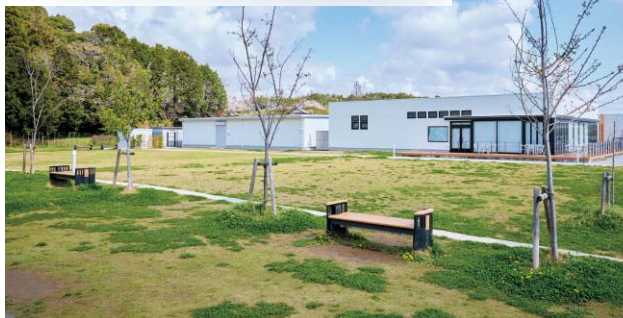
上／「道の駅むつざわ」内にある液晶パネルでは、エネルギーの循環状況がリアルタイムに確認できる 下／施設内には防災広場も設けられている。写真手前のベンチはかまどにもなる防災ベンチだ
