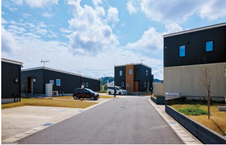
約100人の住民が暮らす住宅エリア。電線はすべて地中化されている。2019年の台風15号では暴風により多くの電柱が倒れ、停電を引き起こしたが、ここでは地中化が功を奏し被害を免れた
