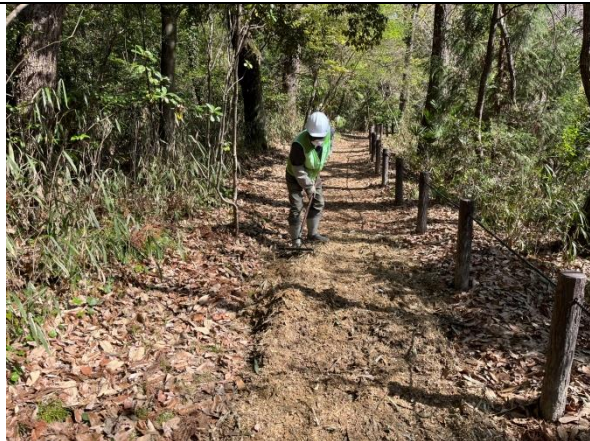
粉砕したチップを、散策路に敷き均します。 削れにくく、歩きやすい散策路になります。
