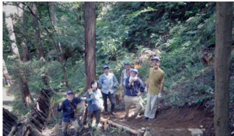
2023/8/26 スギ・ヒノキ人工林作業道の整備
