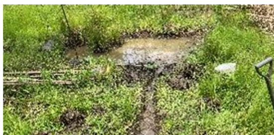
5月27日生きものの池づくり（水路掘り）
