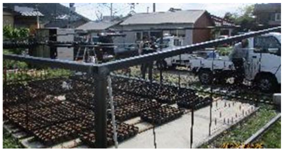
4月28日・防雨装置用鉄骨枠組み工作中
