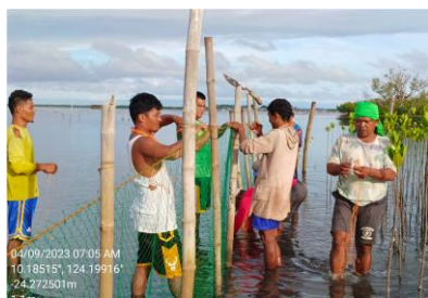
2023 年 4 月 9 日マングローブ保護フェンス修繕
