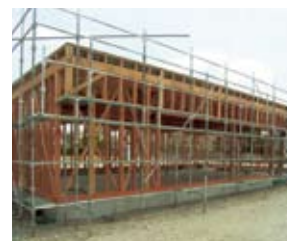
施工中的店铺
