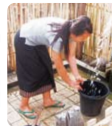
在老挝建成的供水设施
