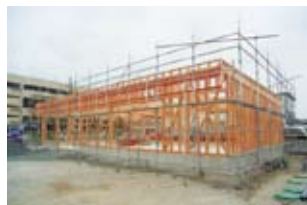
工事中の店舗
