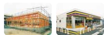
工事中の店舗
