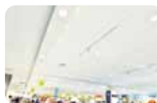
LED照明への切り替え
