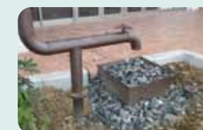
雨水を下水管に直接流さず土壌へ浸透させて浄化する「雨の庭™」
