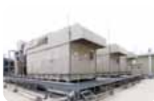
自家発電設備の設置
