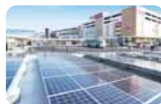
太陽光パネルの設置
