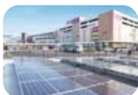
太陽光パネルを設置
