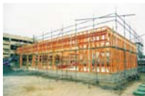
工事中の店舗
