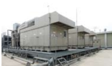
自家発電設備の設置
