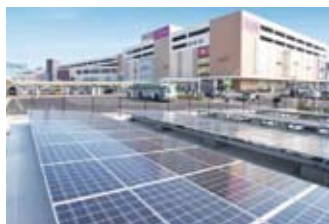
太陽光パネルを設置
