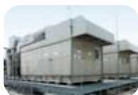
自家発電設備の設置
