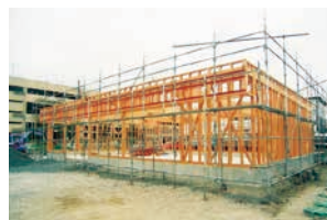
工事中の店舗
