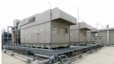
自家発電設備の設置
