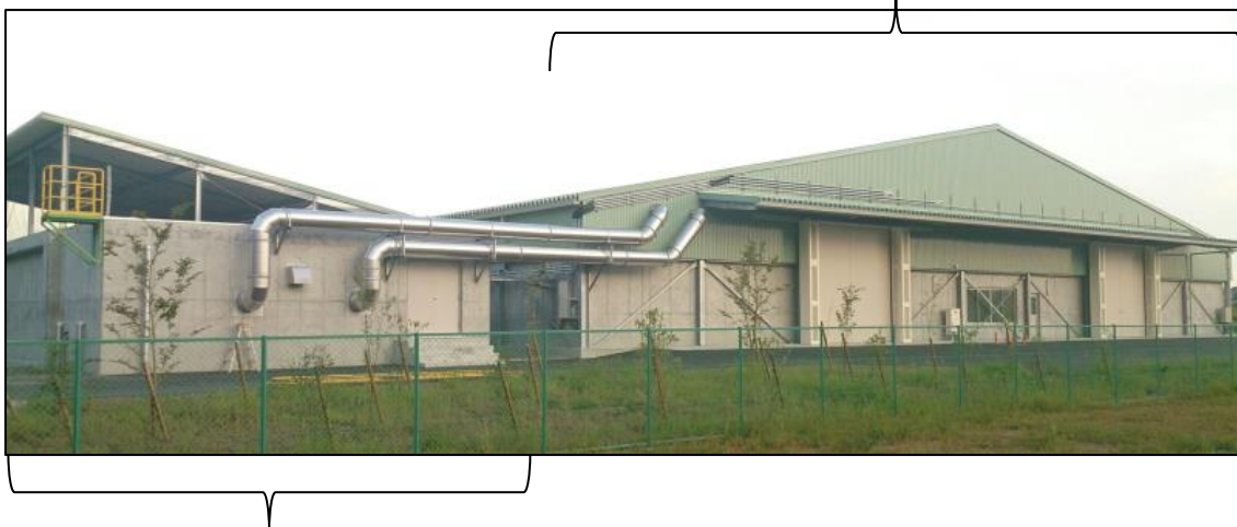
脱臭装置設備
