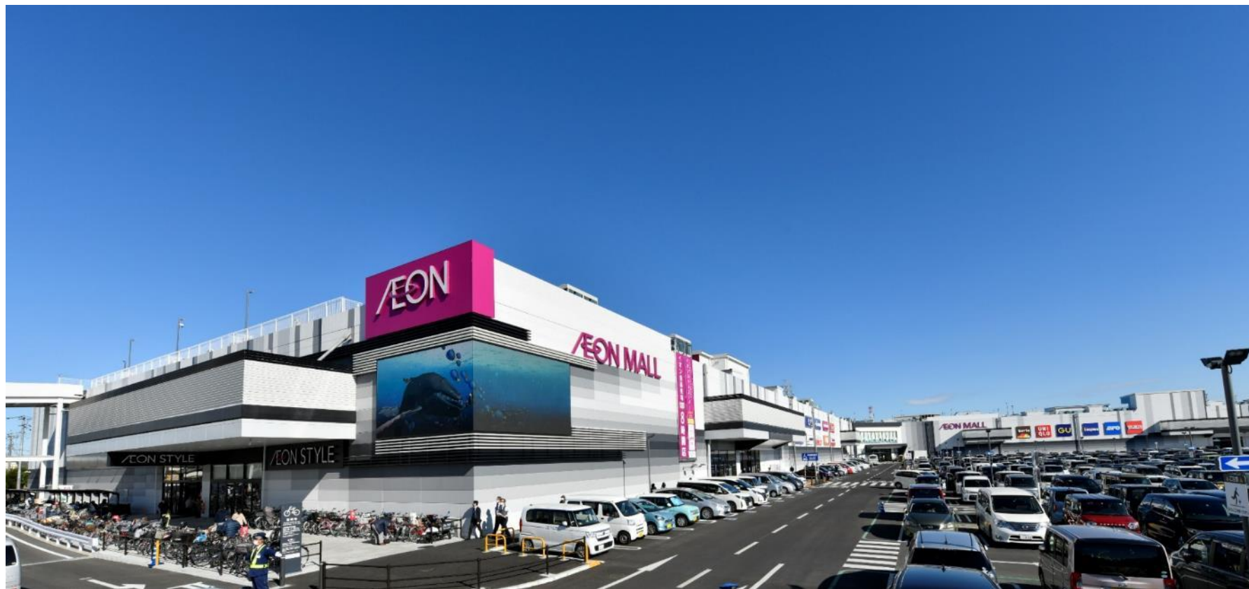
100%再生可能エネルギーで運営されているイオンモール上尾
