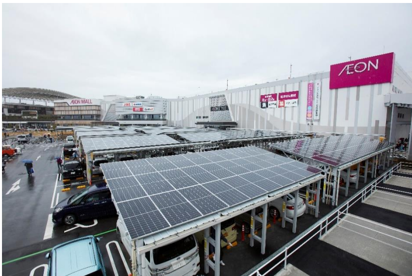
イオンモール豊川に設置したソーラーカーポート
