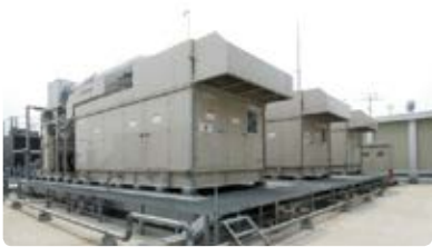
自家発電設備の設置
