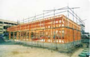
工事中のミニストップ店舗
