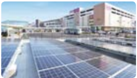
太陽光パネルを設置
