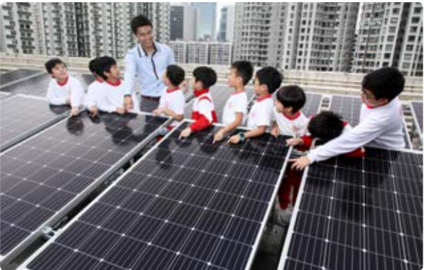
贈呈式後、屋上の太陽光発電システムを見学する生徒と先生 滬江小学(香港)
