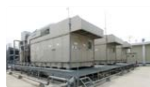
自家発電設備の設置
