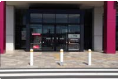
駐車場ポール
