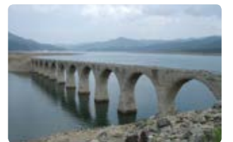
コンクリートアーチ橋梁群での観光トロッコ実験事業推進
