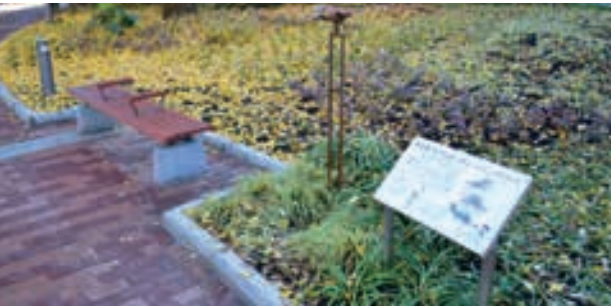
「雨の庭™」 雨水には排気ガスなどに含まれる生態系を壊す恐れがある物質が混入することがあります。「雨の庭™」は、雨水を地中に浸透させて浄化することで、生態系への負の影響を減らします。
