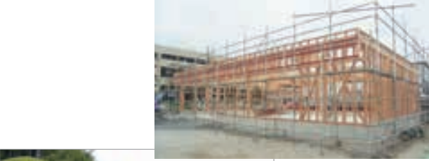
工事中のミニストップ店舗
